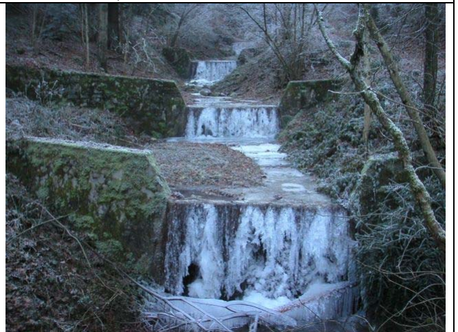
Foto 04.12.16_18 Betonsperren im Malterbach
