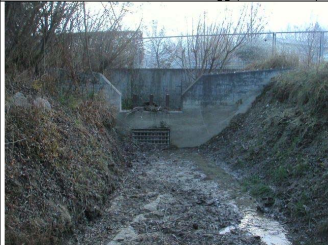
Foto 04.12.15_26 Einlass Bauwerk 83016, Haldenhüslibach, Ober Ei
