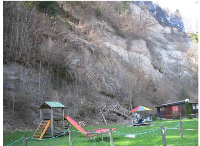
Foto Wo24: Hotel Bad Der zum Hotel/Restaurant gehörende Kinderspielplatz liegt im steinschlaggefährdeten Bereich.
