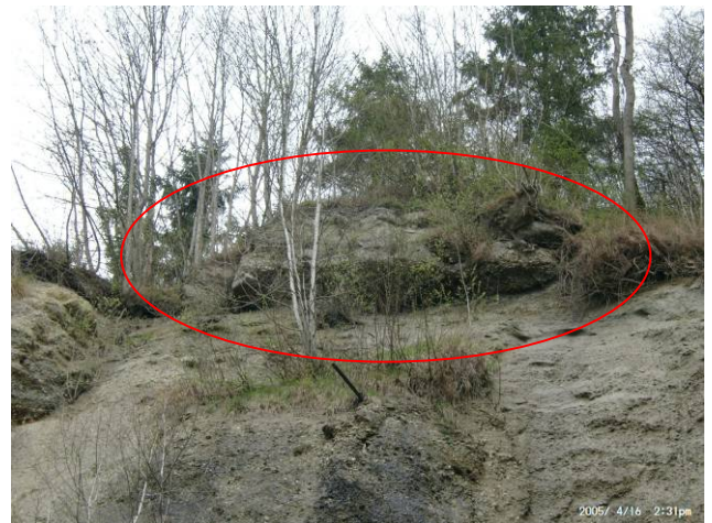
Foto We14: Guggeliberg Im Kopfbereich weist die Felswand überhängende Felspartien auf.
