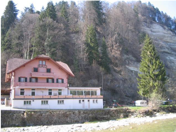
Foto Wo23: Hotel Bad Das Hotel steht direkt vor einem steilen Hang
