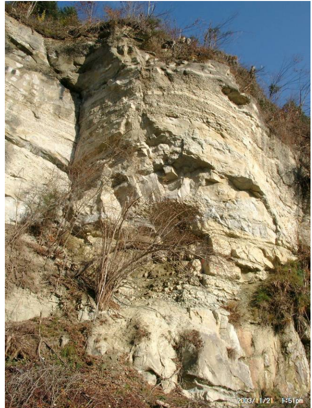
Foto R12: Felswand Dietenei Die Mergelschichten am Fuss des Felsturms wittern rasch heraus, es entsteht ein Überhang. Eine steilstehende wandparallele Kluft hinterschneidet den Felsturm teilweise.
