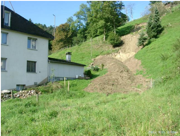
Foto Wo6: Kommetsrüti Unwetter 2005: Hangmure bei Hinter Kommetsrüti. Der Ausbruch ging bis auf den Fels hinunter. Als Notmassnahme wurde ein kleiner Ablenkdammer errichtet.
