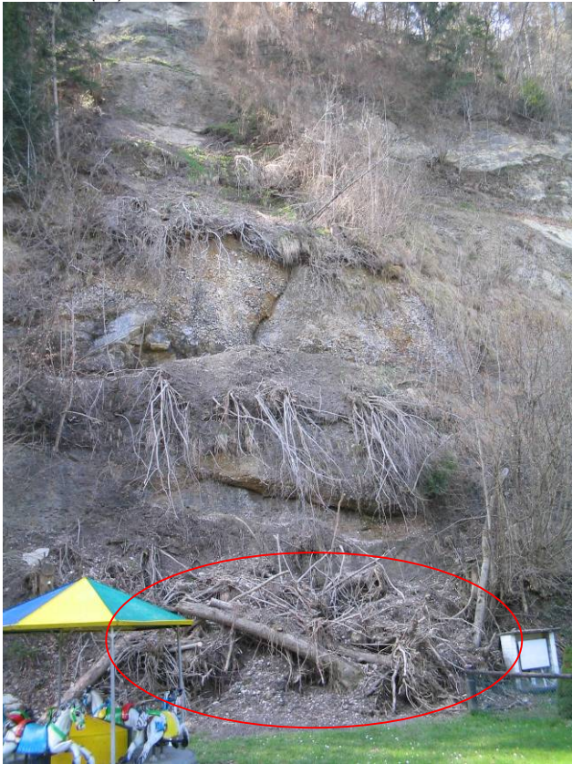
Foto Wo1: Bad Mitsamt Bäumen abgerutschtes Lockergestein am Hangfuss lagert hinter dem Kinderspielplatz.
