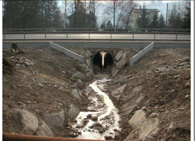
Foto 04.12.15_64 Rohrdurchlass unter der Kantonstrasse am Birehüslibach, westlich Schönebode. Bauwerk 111002
