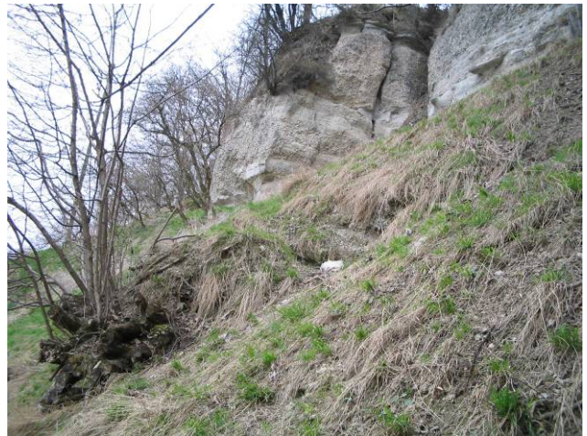
Foto Wo32: Oberhalb Kirche Wolhusen Blick von unten auf den Felsturm. Im Vordergrund ist eine abgeglittene Lockergesteinsscholle im Hang sichtbar.
