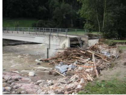
Abbildung 6: Um den Wasser-Massen mehr Raum zu geben, vergrösserte die Kleine Emme oberhalb von Wolhusen durch Ufererosion ihr Bett
