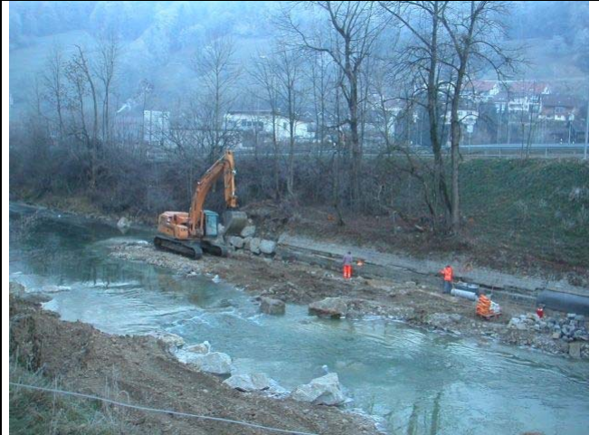
Foto 04.12.15_23 Ausbesserungsarbeiten an Uferbefestigung nahe Hältbüelerbrugg
