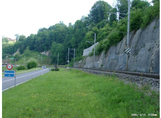
Foto R6: Werthenstein Gegenüber der Klosterkirche: Die Bahnlinie verläuft direkt entlang den Nagelfluh- Felswänden. Blickrichtung Nordwest.
