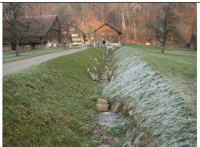
Foto 04.12.15_67 Eindolung mit Blick auf Rohrdurchlass 129003.
