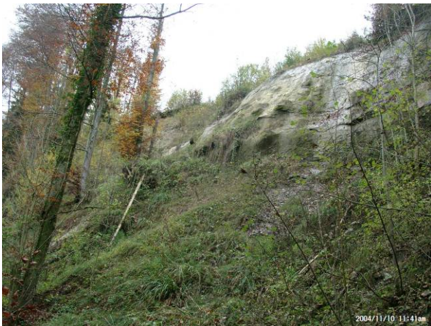
Foto We1: Felswand im Langnauer Wald, W' Schofgrabe, Kote ca. 580 m ü. M. Ober- und unterhalb der Felswand fanden in der jüngeren Vergangenheit schon grössere Rutschungen statt.
