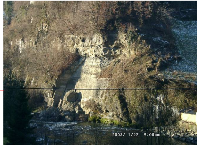
Foto We20: Klosterkirche Werthenstein Januar 2003: Ausbruchsstelle eines Felsausbruches vom Januar 2003. Das im Fluss abgelagerte Sturzmaterial wurde bereits weggebaggert.
