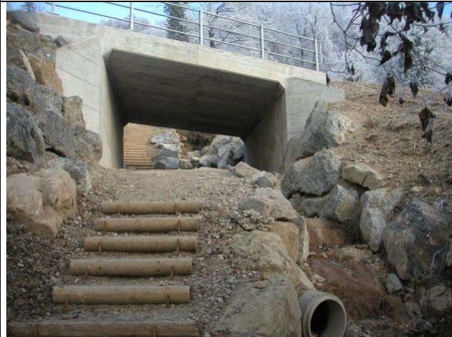
Foto 04.12.15_31 Unterführung mit neu angelegtem Rohrdurchlass Bauwerk 83015, Haldenhüslibach
