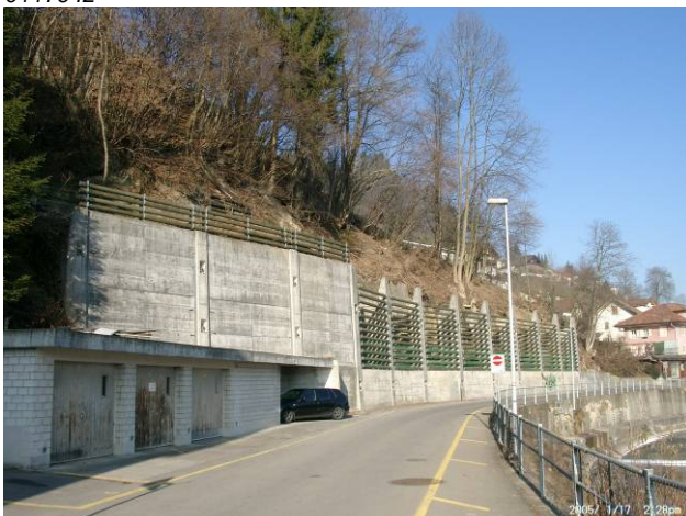
Foto Wo17: N' Kommetsrüti, Kote ca. 580 Schutzbauten neben der Strasse, S' Kommetsrüti 6
