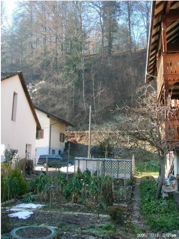
Foto Wo14: N' Kommetsrüti Steiler Hang direkt hinter dem Siedlungsgebiet (Kommetsrüti 8 - 22)
