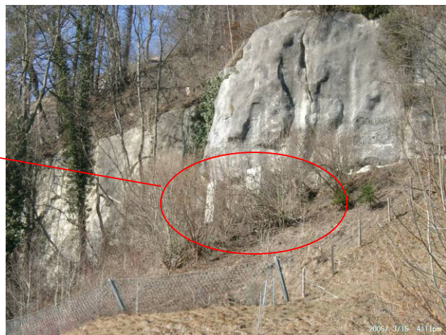
Foto M16: Geisschachen Eine absturzgefährdete Felsmasse mit ca. 300 m 3 Volumen wurden im Jahre 2000 durch zwei mit Felsankern gesicherte Betonrippen gesichert. Zum permanenten Schutz der Liegenschaft sowie der T10 wurde ca. 35 m langes Steinschlagnetz angebracht. Die Felssicherung wird geotechnisch überwacht.
