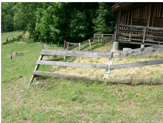
Foto M5: Siedlungsgebiet Halde Im Anrissbereich der Rutschung wird ein Lattenzaun auseinandergezogen
