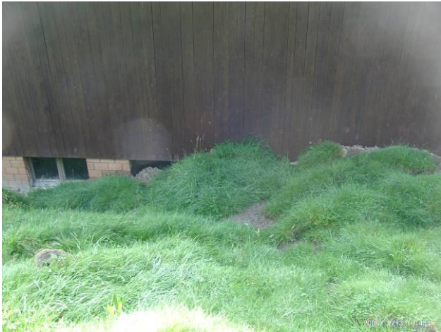
Foto Wo10: Hinter Kommetsrüti, Kote ca. 620 Das abgerutschte Erdmaterial lagerte sich an der Rückseite des Stalles an
