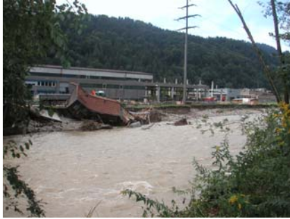
Abbildung 5: Durch Ufererosion zerstörter Schuppen in Schachen
