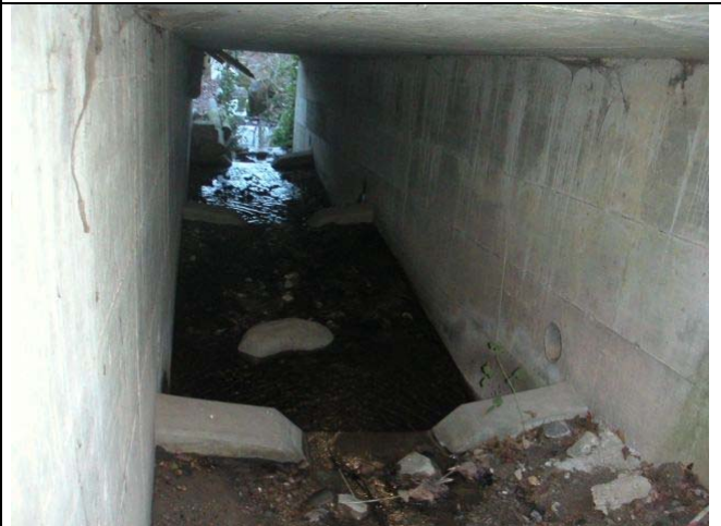
Foto 05.01.05_53 Unterführung mit Kleinschwellen, Luegeteweidbach. Bauwerk 74004
