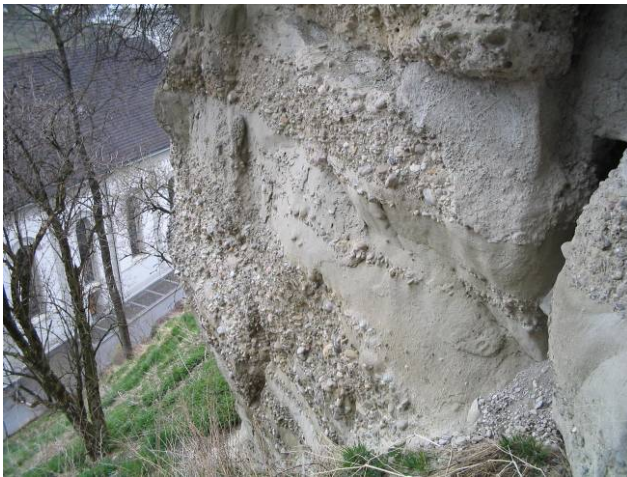
Foto Wo31: Oberhalb Kirche Wolhusen Ein Felsturm ist durch eine steil stehende, wandparallel verlaufende Kluft ruckseitig vom Felsverband getrennt (Offnungsweite ca. 30-40 cm).
