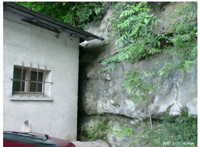
Foto R4: Hauptstrasse bei Werthenstein Haus an der Hauptstrasse. Das Haus steht direkt an der Felswand.
