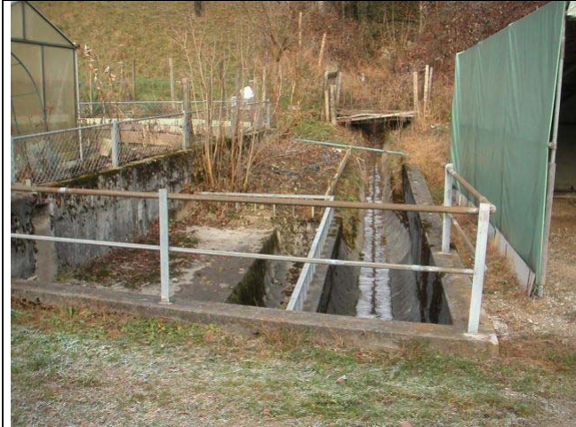
Foto 04.12.15_59 Eindolung und Einlass am Ammergreigebach, westlich Schönebode. Bauwerk 103005
