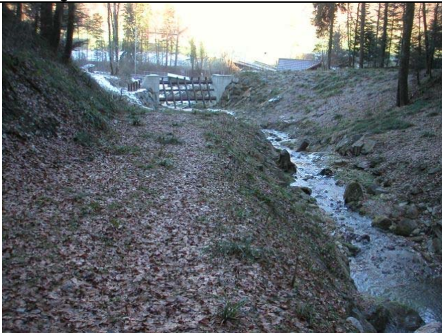
Foto 05.01.05_69 Murgangrechen, Wildholzrückhalt Bauwerk ID 127004, Schofgraben, südlich Langnau
