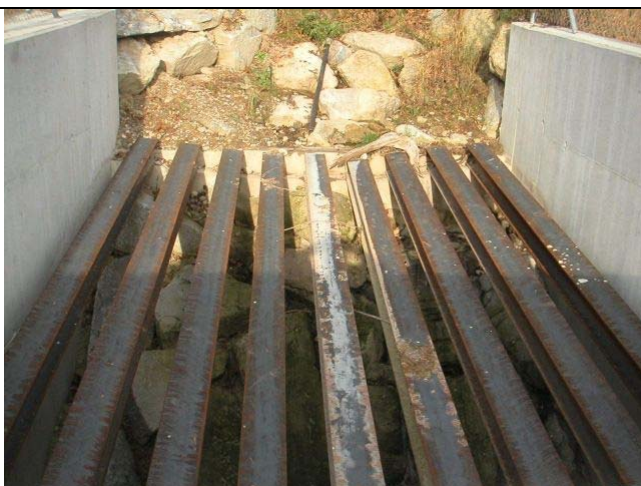
Foto 04.12.15_66 Bauwerk 116001, Durchlass mit Stahlgitter, westlich Unter-Steigle, Unterführung Kantonstrasse
