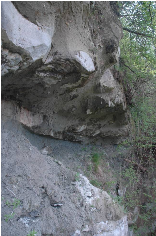
Foto We20a: Felswand unterhalb Klosterkirche 6.5.2006: Überhang unterhalb der Kirchenmauer
