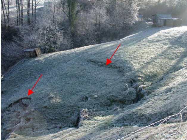
Fotos Wo19: Geländemulde S' Wideweidli, Kote ca. 590 Rutschungsphänomene in der Mulde unterhalb der Strasse
