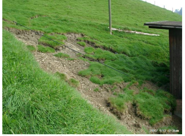
Foto Wo9: Hinter Kommetsrüti, Kote ca. 620 Unwetter August 2005: Eine Stall wurde durch eine Spontanrutschung getroffen
