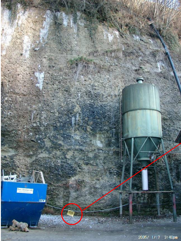
Foto Wo29: Felswand S' Fleuweid Steinschlag- und Eissturznefahr aus der Nagelfluhfelswand hinter dem Sanitargeschaft Renggli Jost AG
