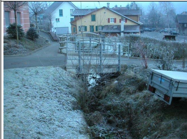
Foto 04.12.16_04 Brücken über dem Chällerhofbach mit engem Durchlass, Bauwerk 68004
