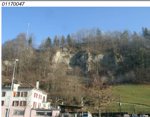
Foto We11: Guggeliberg Die steile Felswand ob. Entlebuecherstrasse 55
