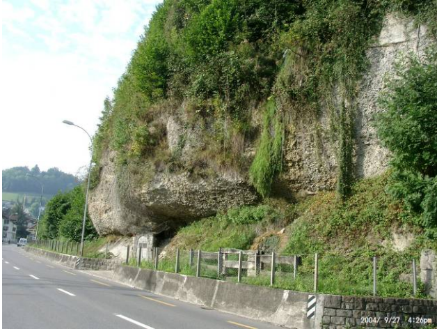
Foto Wo27: Felswände an der Kantonsstrasse, ca. 200m W' des Bahnhofs
