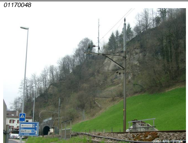
Foto We12: Guggeliberg Unter der Felswand verlaufen zwei Steinschlagnetze
