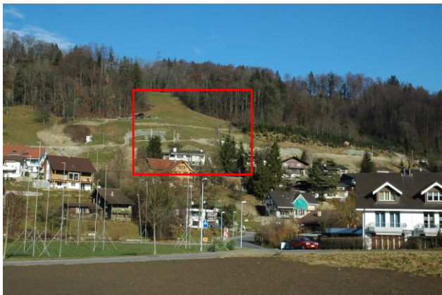
Foto M3: Siedlungsgebiet Halde Der Hang oberhalb der Häuser rutscht.
