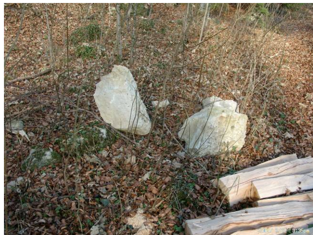
Foto M14: Schwyzerhüsli, Kote ca. 620 Weitere frische Steinschlagzeugen am Hangfuss E' Schwyzerhüsli
