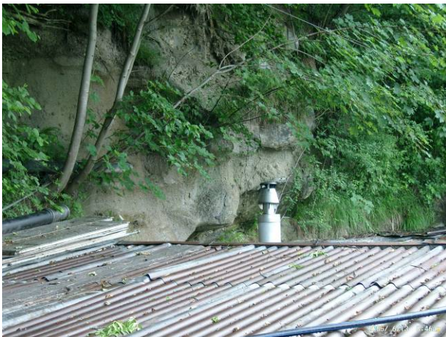
Foto R3: Hauptstrasse bei Werthenstein Haus an der Hauptstrasse. Das Haus steht direkt an der Felswand.
