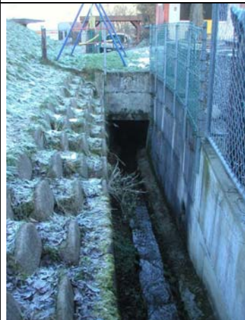
Foto 05.01.05_54 Eindolung und Einlass des Luegeteweidbachs unter die Strasse nach Schwarzenbach. Bauwerk 74005
