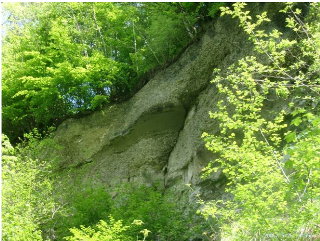
Foto We23: Wanderweg S' Badhus Ganze Wandbereiche sind wandparallel hinterklüftet.
