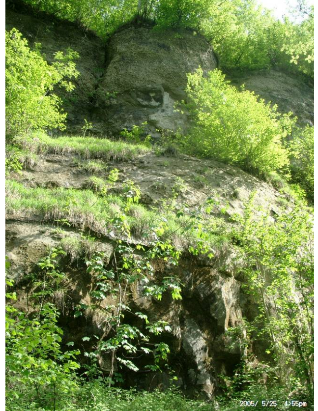
Foto We22: Wanderweg S' Badhus Der Fels besteht vorwiegend aus wechsellagernden Sandstein- und Nagelfluhbänken. Steinschlag- und Kleinblockschlag sind häufig zu erwarten.
