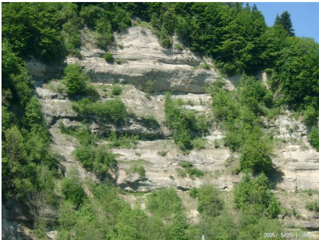
Foto Wo25: Felswand N' Bad Felswand mit massiven überhängenden Sandsteinbänken. Die Felswand steht am Westufer der Kleinen Emme. Abbrechende Gesteinsmassen stürzen in den Fluss. Als Restgefährdungsszenario wäre bei einem grossen Ausbruch (Felssturz) eine Aufstauung des Flusses denkbar.
