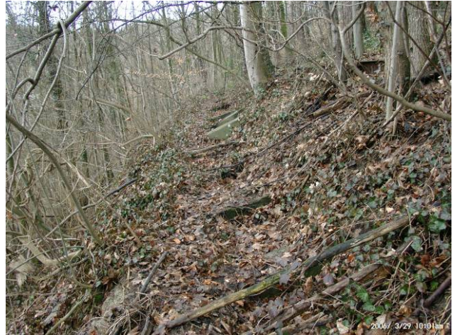
Foto L6: Hang NW' Fabrickgebäude Von Moos Stahl Alte Stützbauwerke aus Beton im oberen Bereich der Böschung
