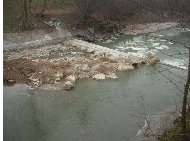
Foto 04.12.14_21 Ausbesserungsarbeiten an Schwellen im Bett der Kleinen Emme, nahe Hältbüelerbrugg (flussabwärts).
