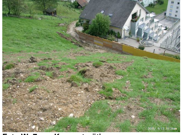
Foto Wo7: Kommetsrüti Unwetter August 2005: Hinter den Terrassenhäusern wurden als Notmassnahme Bretterpallisaden zum Schutz vor den Hangmuren errichtet.
