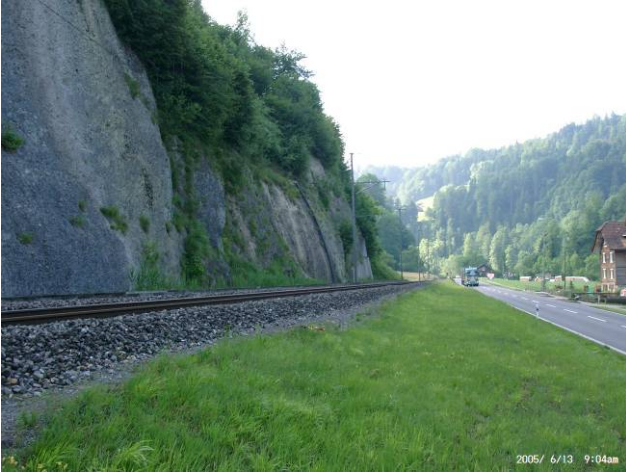
Foto R5: Werthenstein Gegenüber der Klosterkirche: Die Bahnlinie verläuft direkt entlang den Nagelfluh- Felswänden. Blickrichtung Südost.
