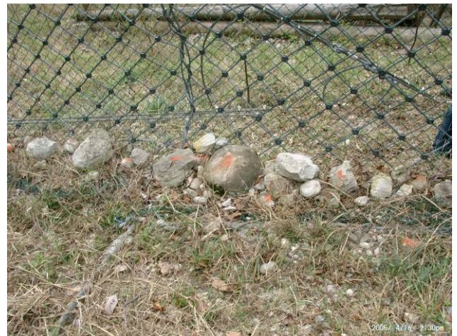
Foto We16: Guggeliberg Das obere Netz ist mit etlichen Steinen hinterfüllt.
