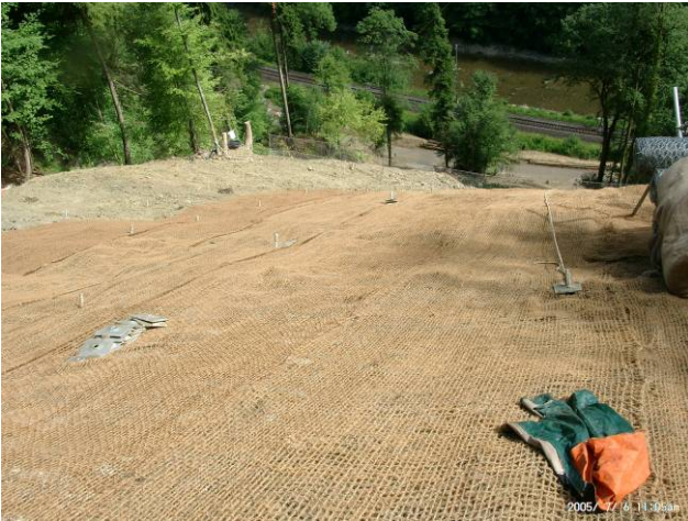
Foto We7: Langnauer Wald, Ängelgraben Kote ca. 590 m ü. M. Im Mai 2005 wurde mit der Sanierung begonnen
