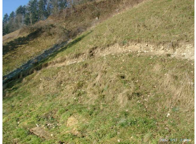
Foto Wo5: Kommetsrüti Risse im Lockergestein im S' Hang Kommetsrüti
