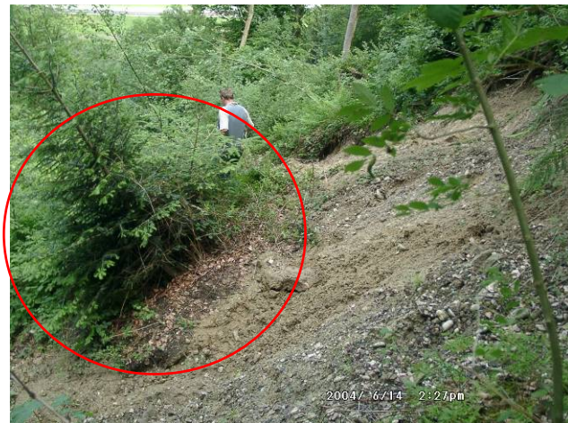
Foto We3: Langnauer Wald, Ängelgraben, Kote ca. 620 m ü. M. Nach der Hangmure rutschten immer wieder einzelne Erdschollen nach (Kreis).
