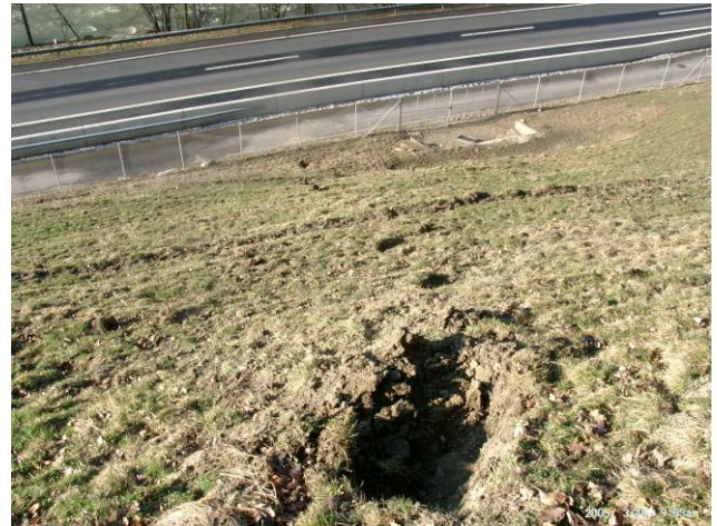
Foto R18: Unterhalb Felswand W' Muffehus Ein einzelner Kleinblock stürzte über die Wiesenböschung bis zur Strasse. Die Einschlagtrichter haben Abstände von 2 bis 5 m.
